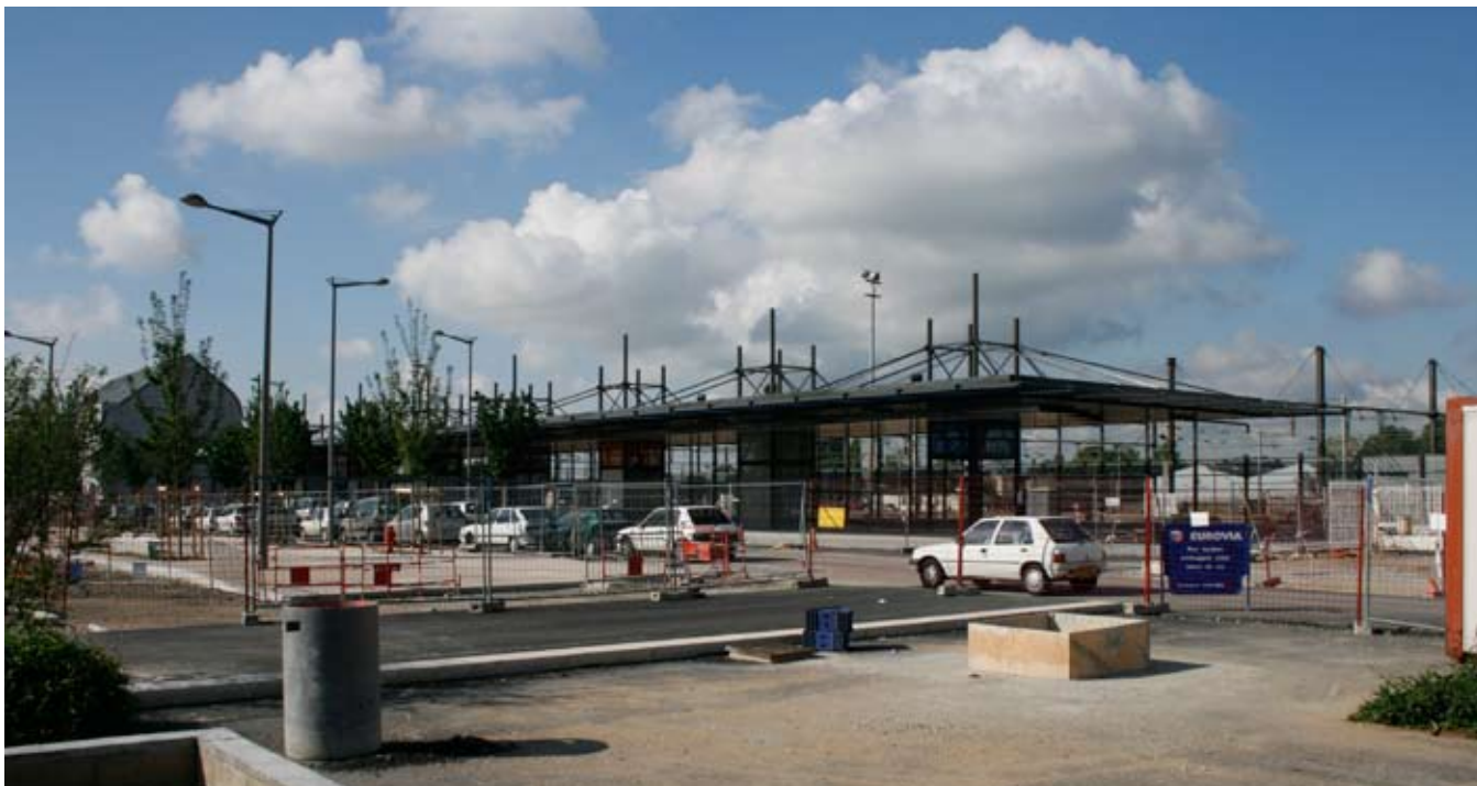
Vue générale façade Est
